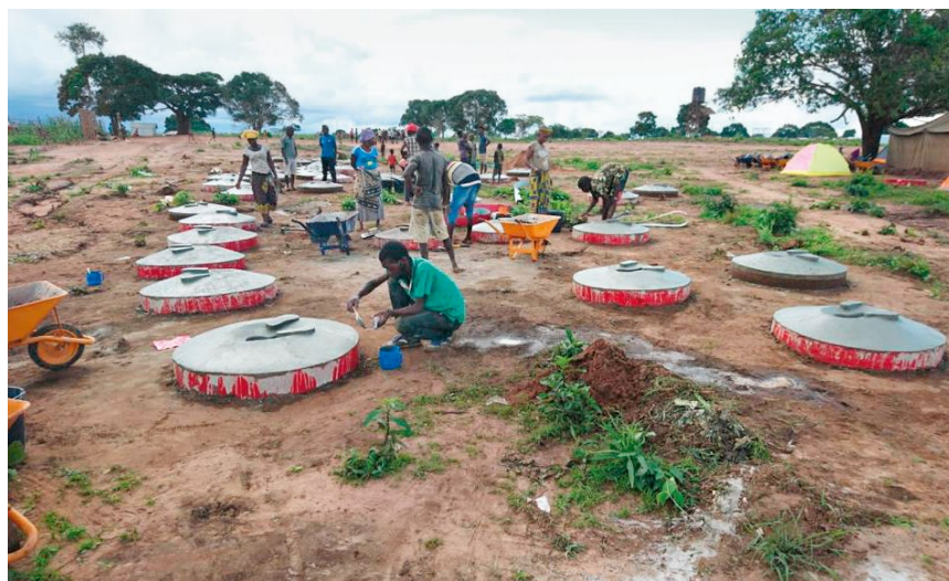
Tous ceux et celles qui le peuvent participent à la fabrication de dalles en béton pour les latrines.
